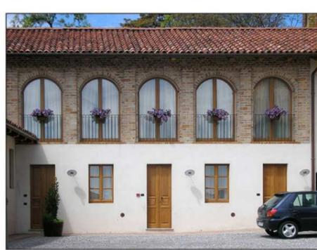
7\_ALA CAMERE EX FIENILE, le grandi aperture del fienile sono state ricostruite fedelmente seguendo le misure di chiave di volta, d'imposta e fattura
